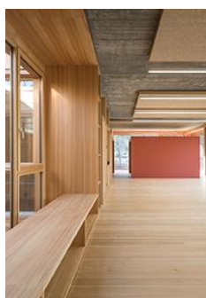
Silber Schreinerarbeiten Sanierung Haus 8, Kli- nik Beverin, Cazis GR Bild Ingo Rasp
