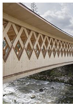
Bronze Holzbauteil Passerelle des Buissons, Bulle FR Bild Vincent Jendly
